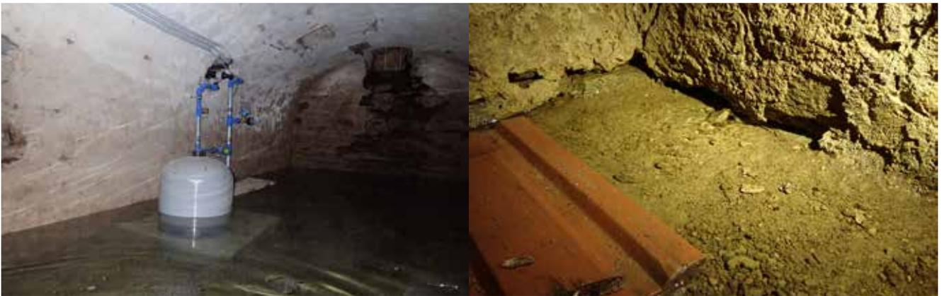
Abb. 2: Der starke Regen der vergangenen Tage (KW37 und 38 des Jahres 2024) hat Grundwasser in den Erdkeller gedrückt. Nach wenigen Tagen war der Wasserspiegel wieder gesunken und nur mehr ein geringer Grundwassereintritt zu beobachten.
