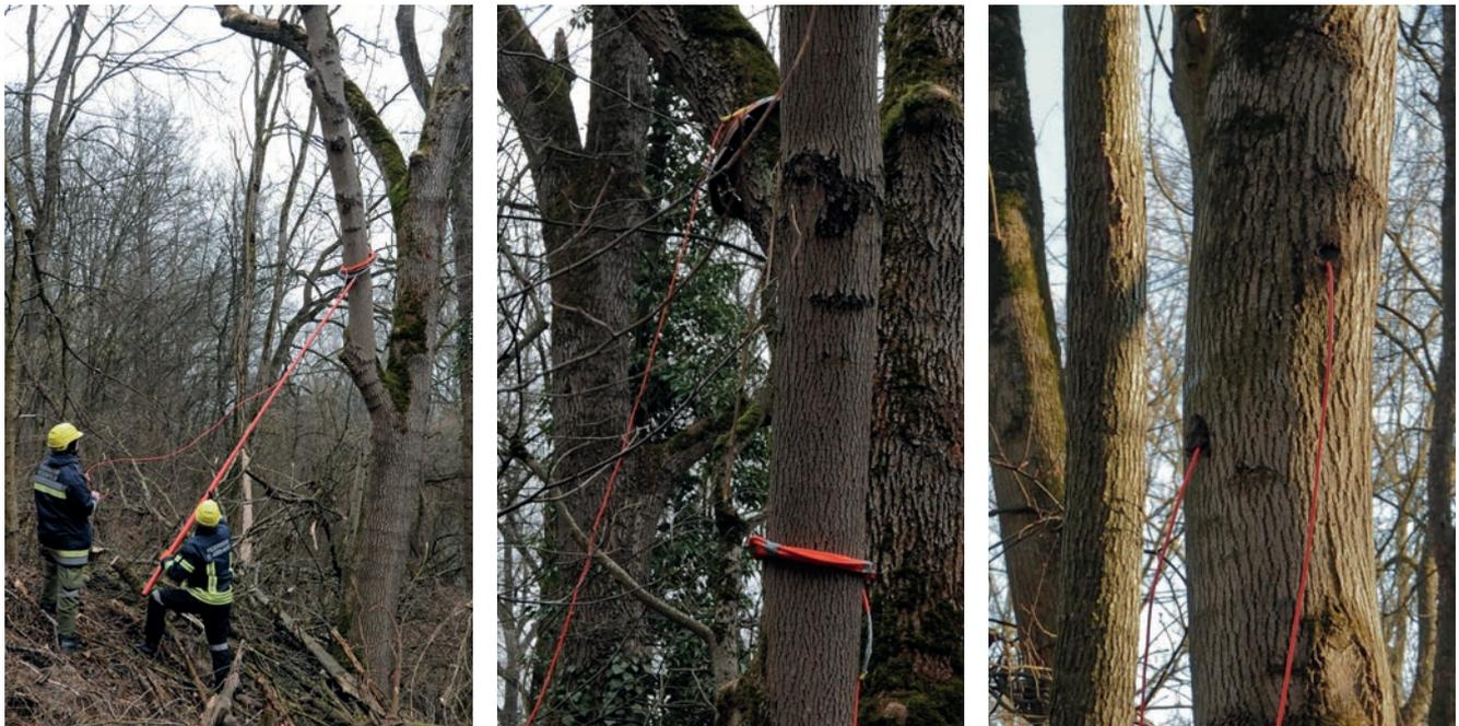
Abb. 5: Anbringung der Sprengschnur außen (links, Mitte) und des Sprengmittels in vorgebohrten Löchern.
