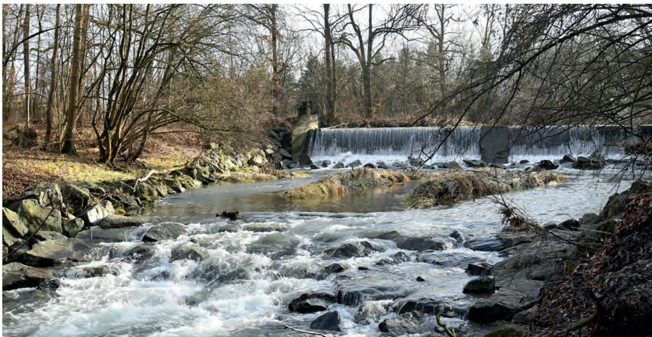
Abb. 11: Das alte Pranklwehr könnte durch einen Tümpel-Becken-Pass für Fische wieder passierbar gemacht werden. Wegen der geringen Wasserführung und der problematischen Umweltauswirkungen sollte jedoch auf eine Wasserkraftnutzung verzichtet werden.
