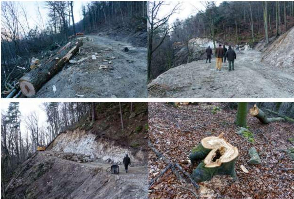
Abb. 3-7: Die Bilder zeigen die enormen Eingriffe in den Waldbestand im Zuge des Trassenaushiebs und in das Bodenrelief mit abschnittswisen Felsbereichen und hohen Hanganschnitten sowie massiven instabilen Schüttböschungen. Aufnahmen: 14.02.21 (E. Kraus)
