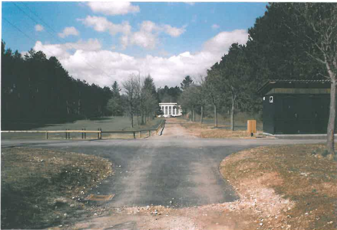
Abb. 13: Brunnenfeld vor der Eröffnung (April 1995, Foto: H. Seehofer)
