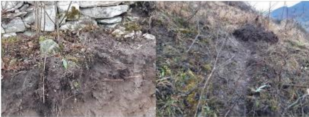
Abbildungen 9 und 10: Meterhohe Abbruchkante nach Baggerung des Trockenrasens - mit Orchideenrosette der Adriatischen Riemenzungen ( Himantoglossum adriaticum ) oberhalb der Abbruchkante (linkes Bild) Spurrillen durch Raupenfahrzeug zwischen bzw. durch Orchideenrosetten (rechtes Bild)
