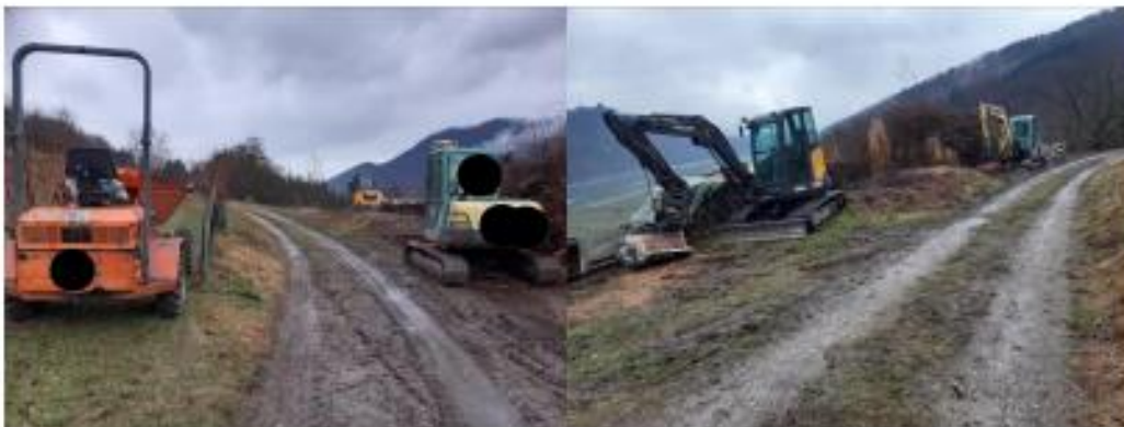
Abbildungen 14 und 15: Auf Gs[redacted] zum Einsatz gekommene Fahrzeuge: Zwei Raupen-Bagger sowie ein Kipplader der Firma [redacted]
